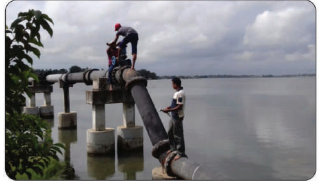
මඩකලපුව ප්‍රධාන සම්ප්‍රේෂණ මාර්ගයෙහි වායු වැල්වය සේවා (නඩත්තු) කිරීම
