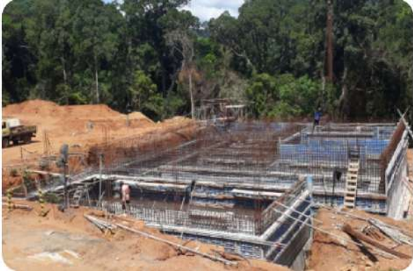
ජල ප්‍රතිකාරක යන්ත්‍රාගාර පරිශ්‍රය තුළ පිරිසිදු ජල ජලාශය ඉදි කිරීම
