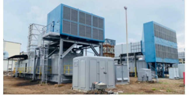
உரு G5: புனரமைக்கப்பட்ட Frame V எரிவாயு விசையாழிகள்
